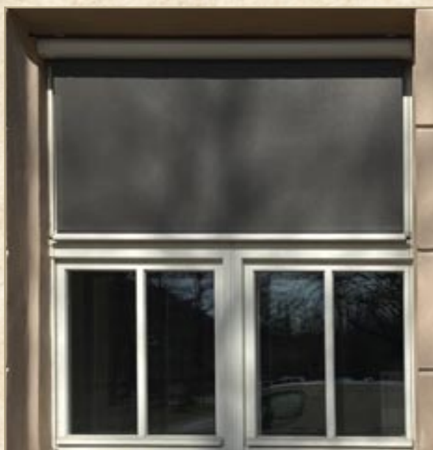
Außenansicht (7,3 cm Kasten, in die Laibung montiert)
