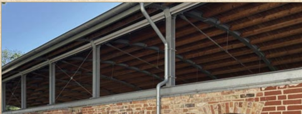
Wetterschutzrollos Klosterruine Altfriedland
