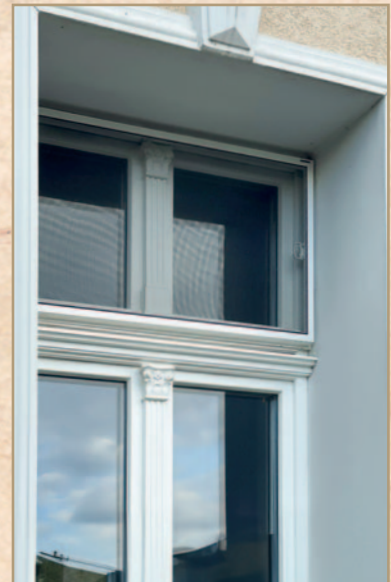
Insektenschutzrahmen für Fenster mit Zierprofilen
