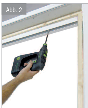
Abb. 2: Obere Führungsschiene und untere schwarze Gleitschiene montieren
