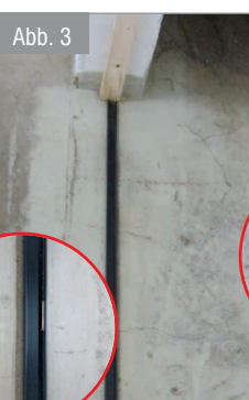
Abb. 2: Obere Führungsschiene und untere schwarze Gleitschiene montieren
